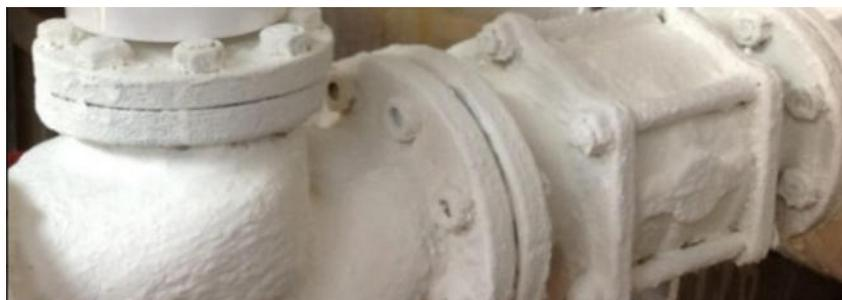
*Рис. Оборудование, обработанное жидкой теплоизоляцией*
